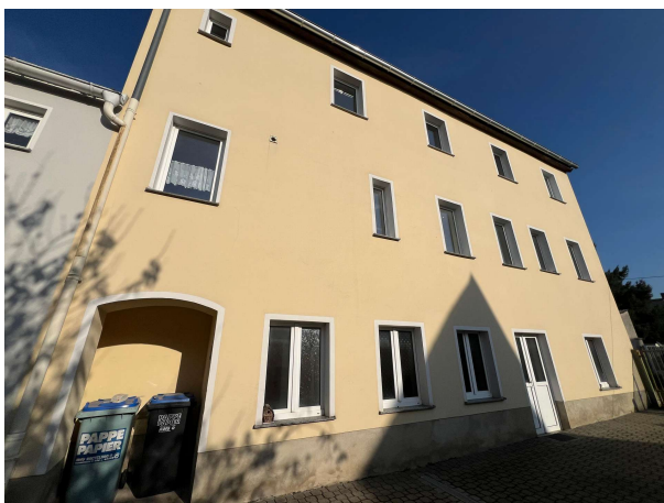
Hinterhaus saniert MFH
