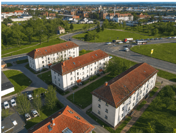
Blick auf die Anlage
