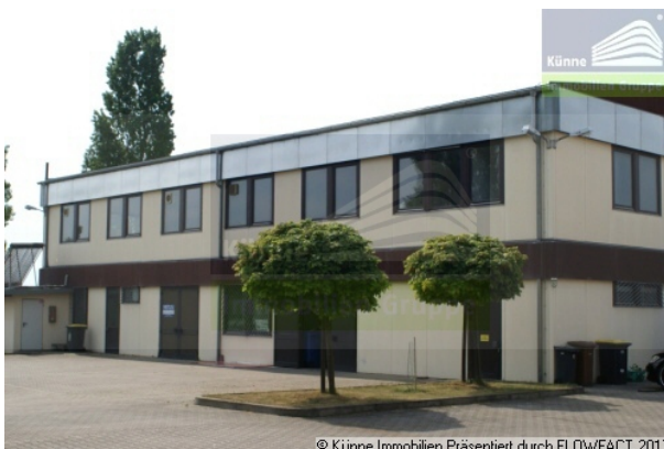
Gewerbe- und Bürogebäude
