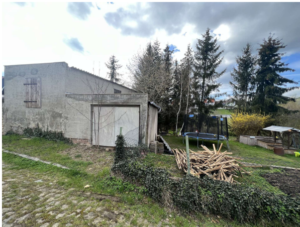
Alter Stall/ Garagengebäude
