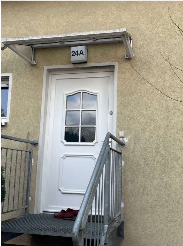
Reihenhaus A Eingangsbereich
