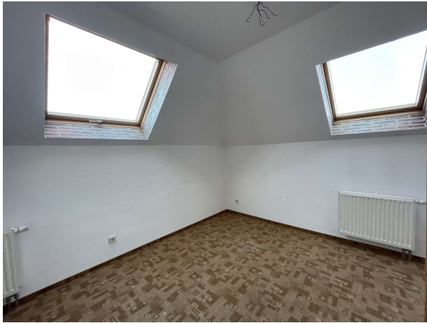
Wohnraum DG vor Renovierung
