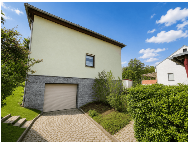
Straßenansicht - Einfahrt Garage
