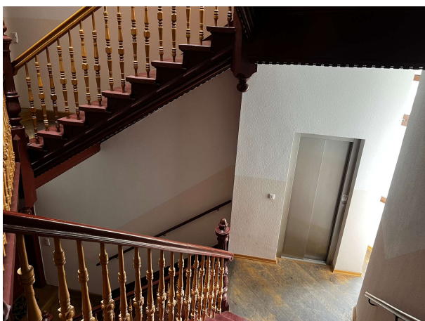
Treppenhaus mit Fahrstuhl
