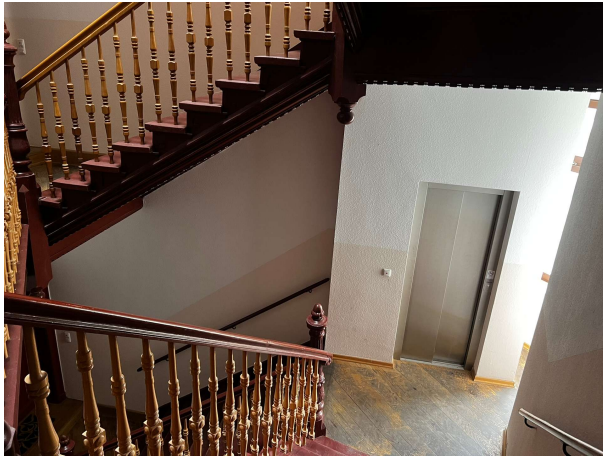
Treppenhaus mit Fahrstuhl
