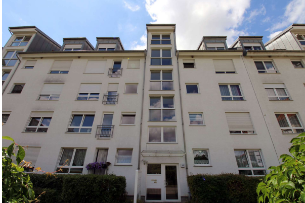
Ansicht auf das Haus von hinten
