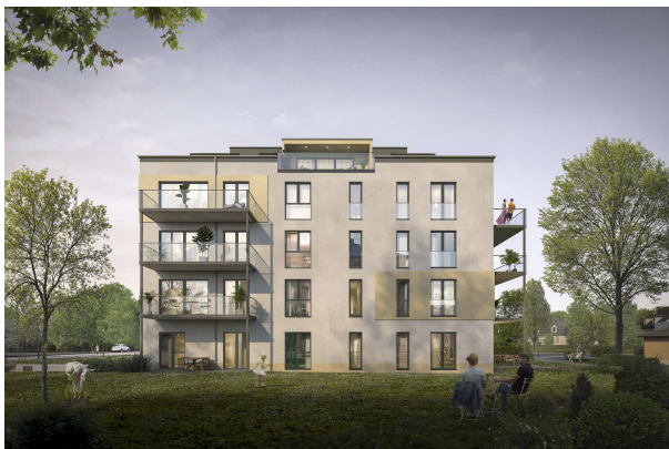
Außenansicht mit Balkonanlage
